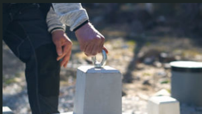
01 Skruva fast lyftögla på grundplinten.
