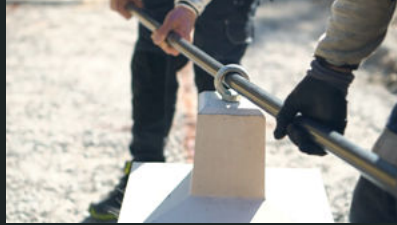
02 Nosta pilari paikoilleen
