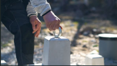
01 Kierrä nostokorva perustuspilariin
